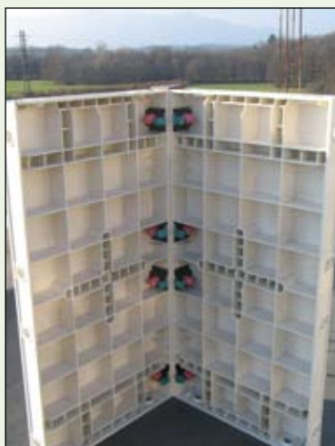
Dokončený roh z venkovní (montážní) strany
