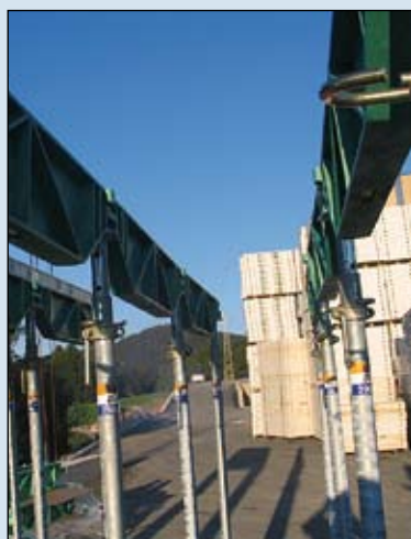
Vzdálenost mezi nosníky SPEED musí být vždy 70 cm.
