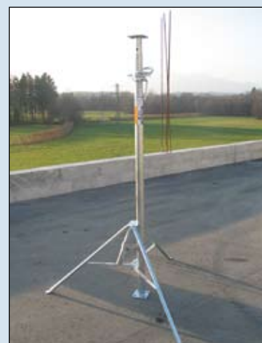
Připevněte stojku do trojnožky.
