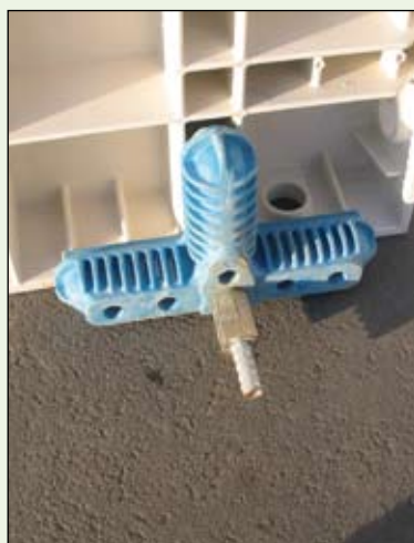
Na spodní třístranné rozpěry je ve většině případů nutné použít normální matku na místo křídlové.
