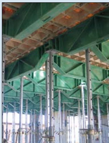
Systém EPIC ECO SPEED umožňuje libovolné umístění nosníků.
