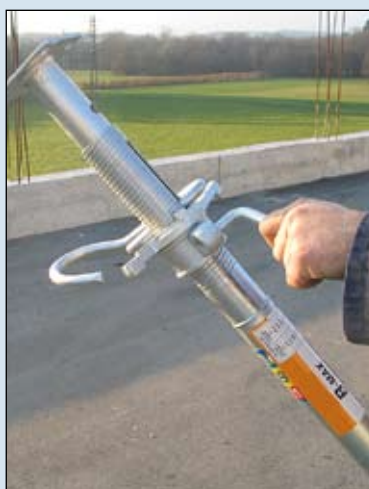
Nastavte šalovací stojky do správné výšky.
