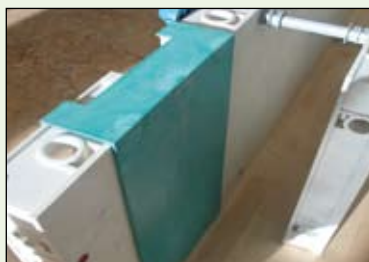
Tento korekční díl lze použít na místo dřeva vyrovnáte s ním až 13,3 cm.
