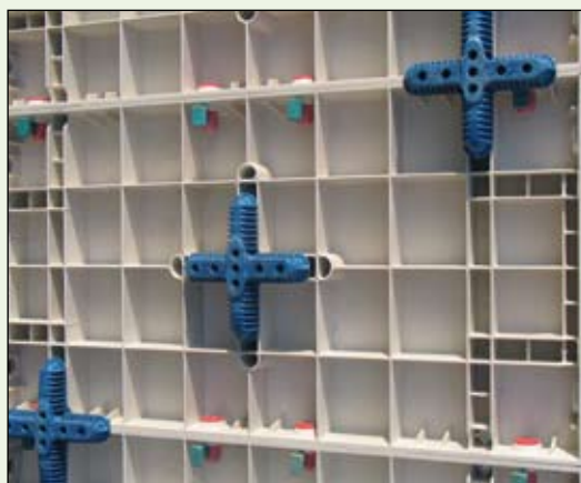
Čtyř strané příčné rozpěry jsou vždy umístěny diagonálně tak jak je ukázáno na tomto obrázku.
