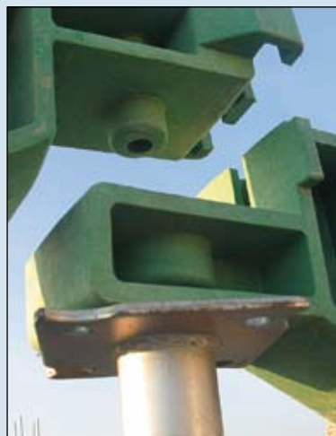
Nasuňte nosník do dalšího nosníku tak jak je ukázáno na obrázku.
