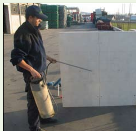
Před použitím bednění je třeba bednění postříkat bednicím olejem z obou stran.
