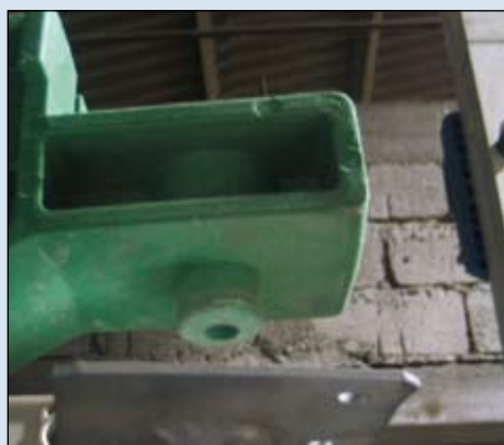
Nasadte nosník EPIC ECO SPEED na šalovací stojku šalovací stojka nesmí mít širší vrchní plochu více než 12 cm a díra v ní nesmí být menší než 4 cm.
