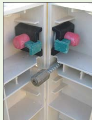
Při křížení diwidag tyčí je prvně třeba nainstalovat normální matku a teprve potom matku křídlovou na druhou.
