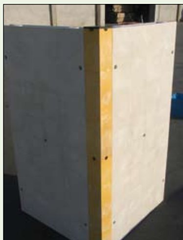
Dokončený roh z vnitřní strany.
