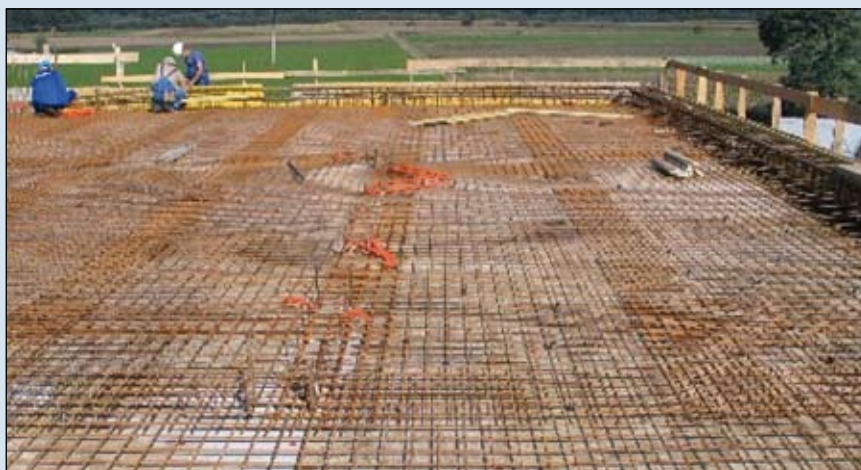
Po dokončení a dokonalém vyrovnání stropního bednění a ucpání nepoužitých děr můžete začít s instalací armatur a potřebné instalace. Po té už můžete začít s vyléváním betonem.
