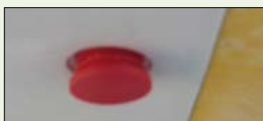
Nepoužité díry v bednění je třeba ucpat ucpávkou.
