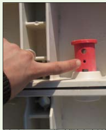
Pokračujte v montáži dalších bednících dílců vždy se ujistěte že je kontrolní bod na čepu směrem k vám.
