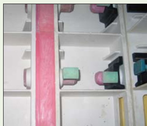
V případě potřeby kruhového bednění je možné použít zkosených dílců, zde je také potřeba použití prodloužených čepů. Při bednění v šachtách usnadní tyto dílce demontáž bednění.
