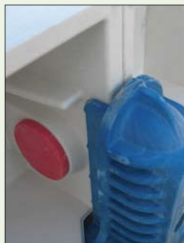
Na spoj bednících dílců umístěte příčnou rozpěru.
