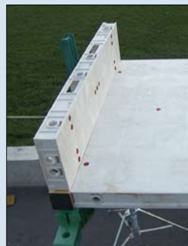
Na konec bednění je třeba umístit zakončovací panel.
