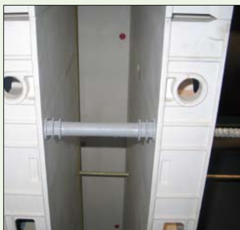
Mezery mezi bedněním je (tloušťka stěny) standardně 15,20,25,30 je třeba osadit distanční tyčí která zabezpečí přesné vyrovnání bednění.
