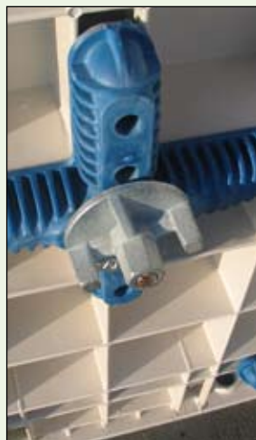
Vložte diwidag tyč a zajistěte ji křídlovou matkou.
